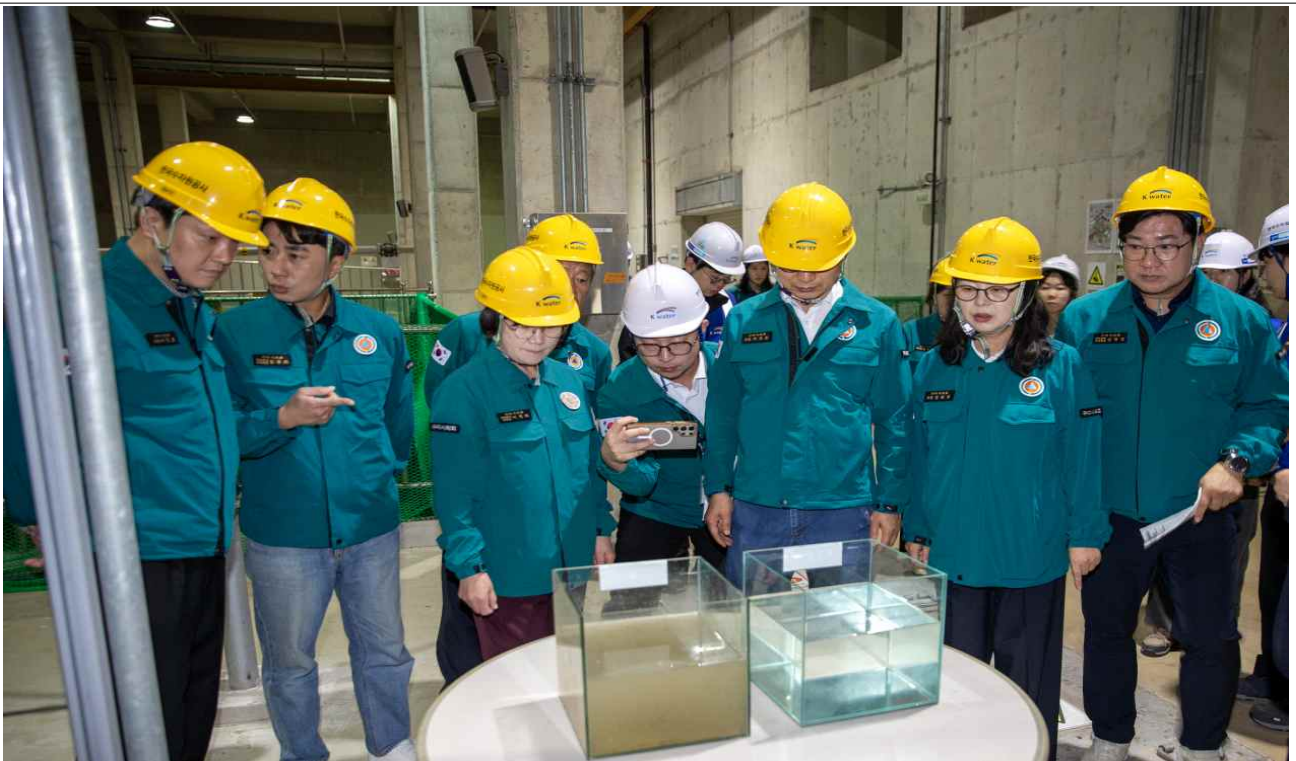
구미하이테크밸리 공공폐수처리시설 시설 점검·확인
